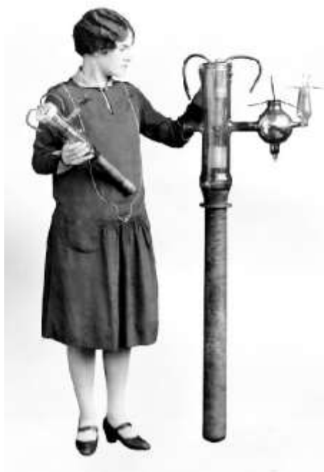
UV-207 (GE) adótriódák. A kisebb a 20 kW-os, a nagyobb a későbbi 100 kW-os változat
